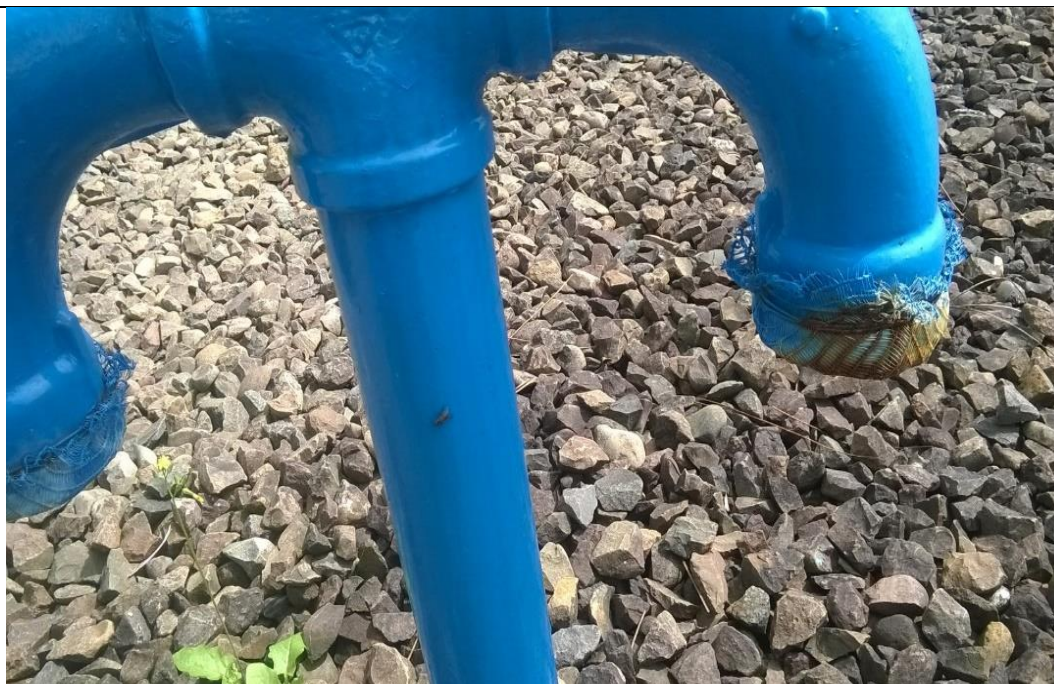
Figura 38: ventilação protegida com tela
