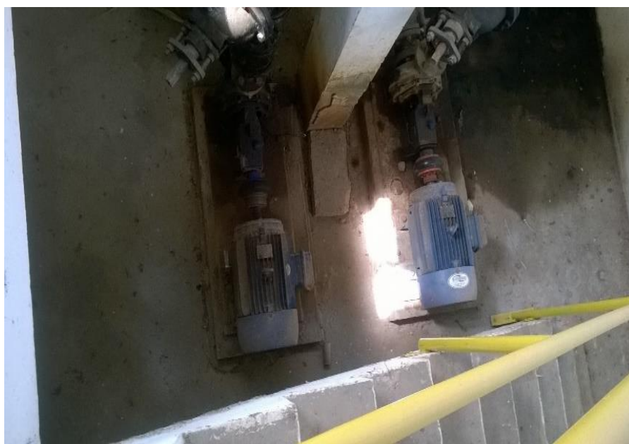
Figura 6: acesso aos motores
