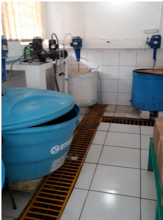
Figura 20: Casa da Química
