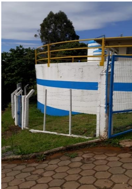
Figura 13. Lado esquerdo da ETA
