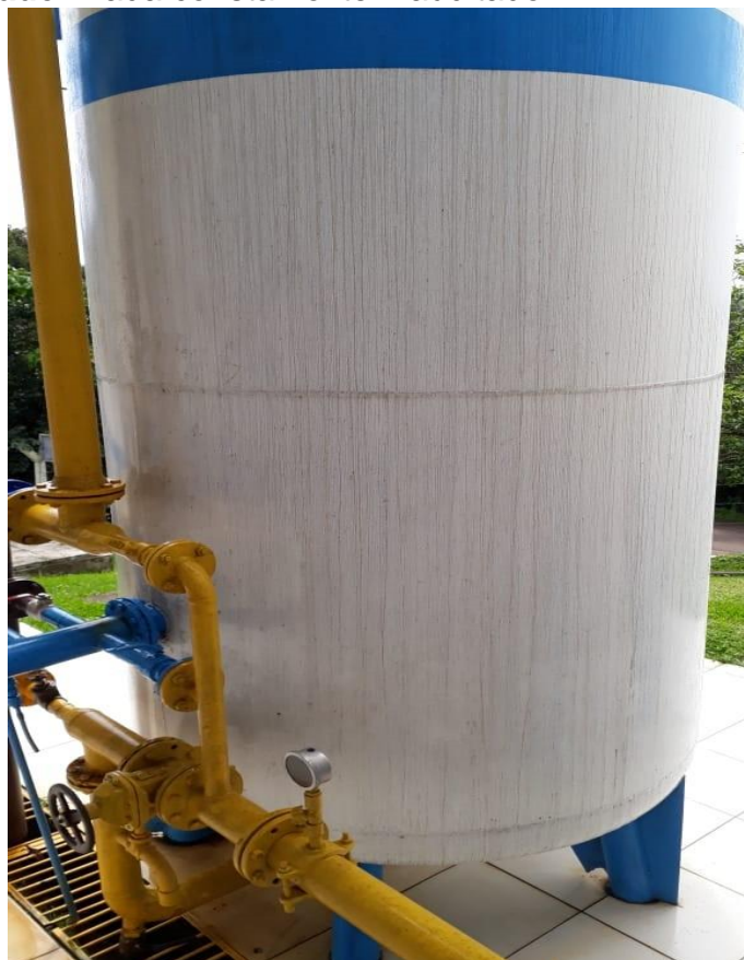
Figura 17: tubulação filtro pressurizado
