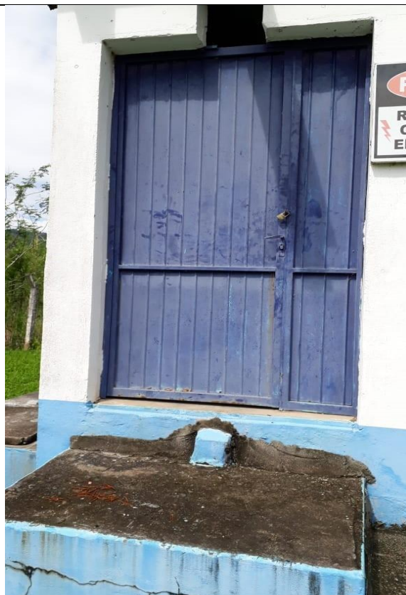
Figura 7: porta acesso a casa dos motores
