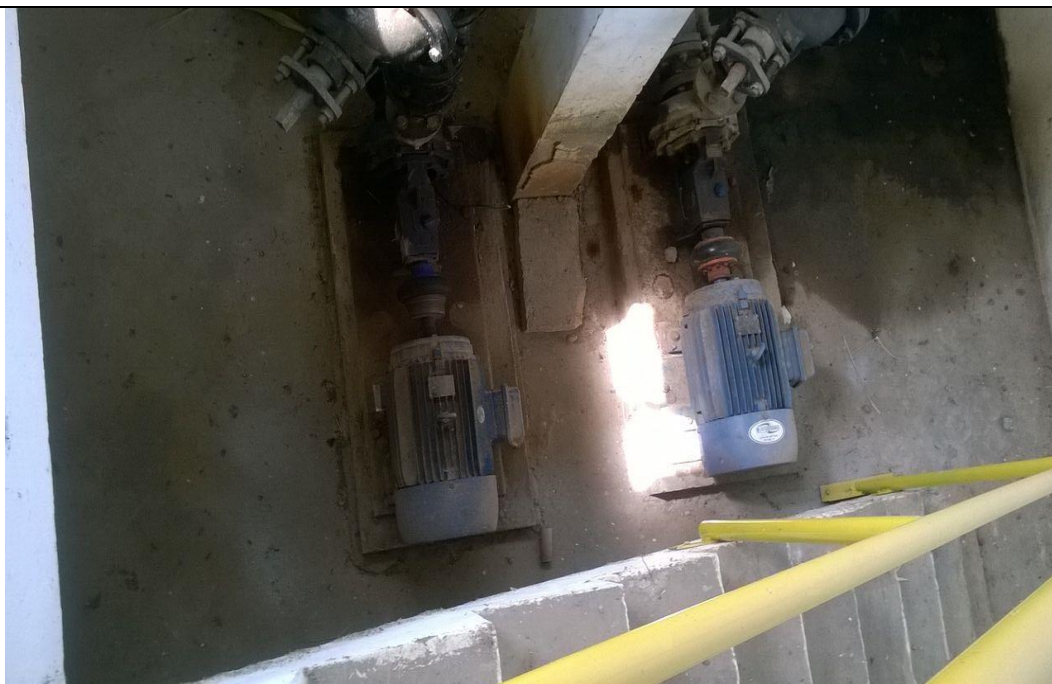
Figura 8: conjunto de motor-bomba
