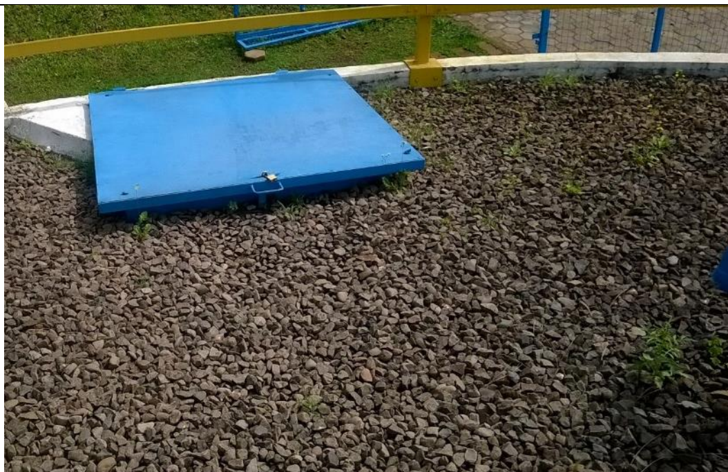
Figura 37: tampa reservatório
