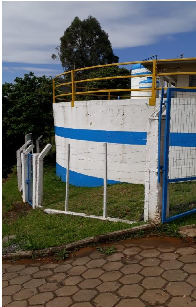
Figura 36: vista externa isolamento reservatório
