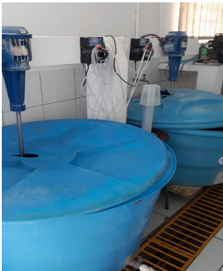
Figura 41: sistema de cloração e flúor
