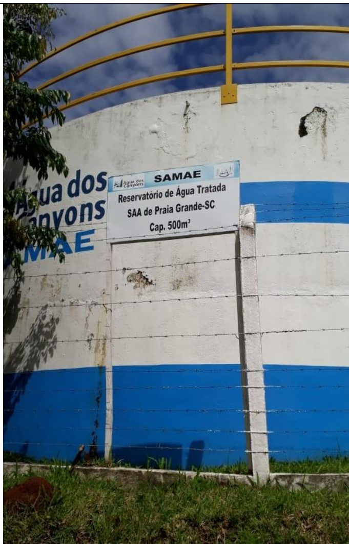
Figura 35: reservatório identificado e cercado
