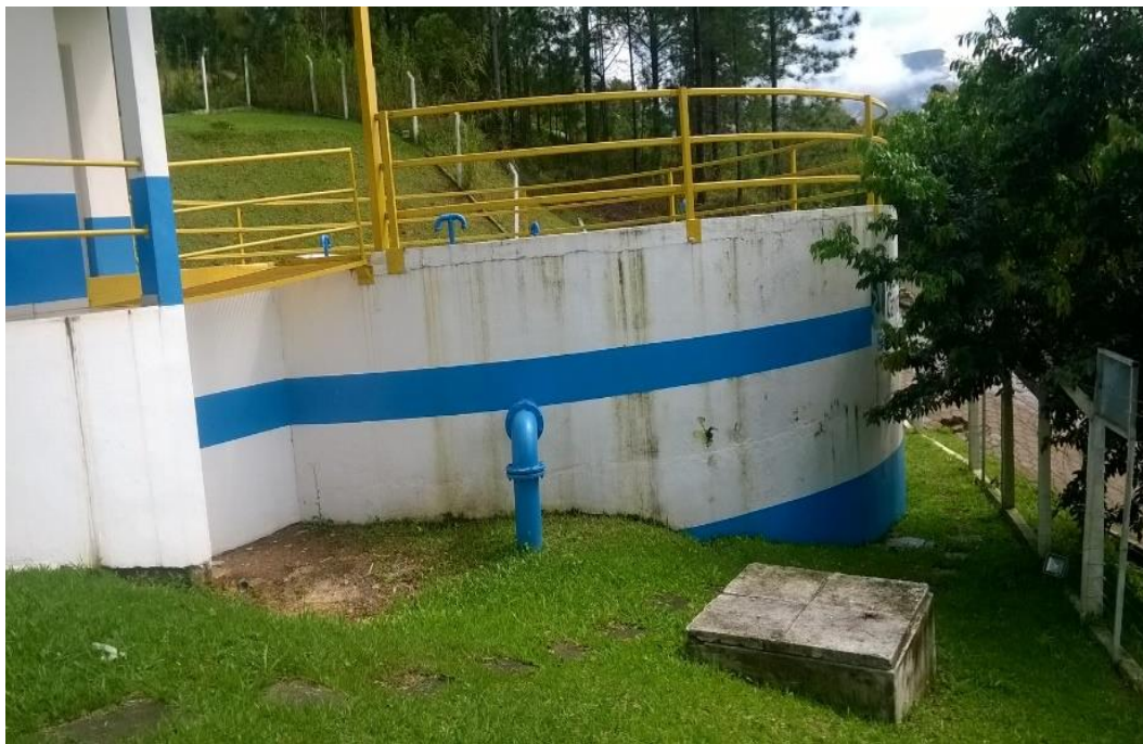
Figura 42: caixa de inspeção
