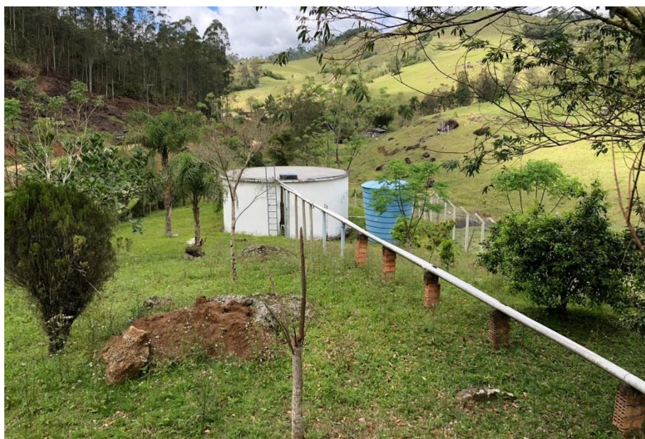
Figura 5: cerca da ETA
