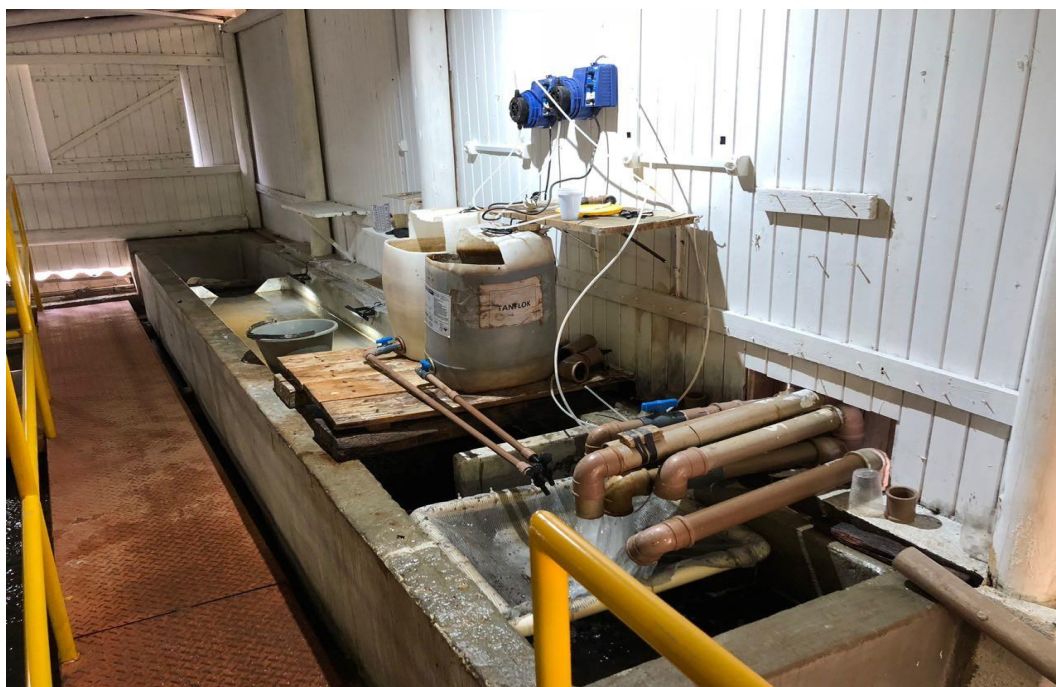
Figura 8: chegada da água à estação tratamento
