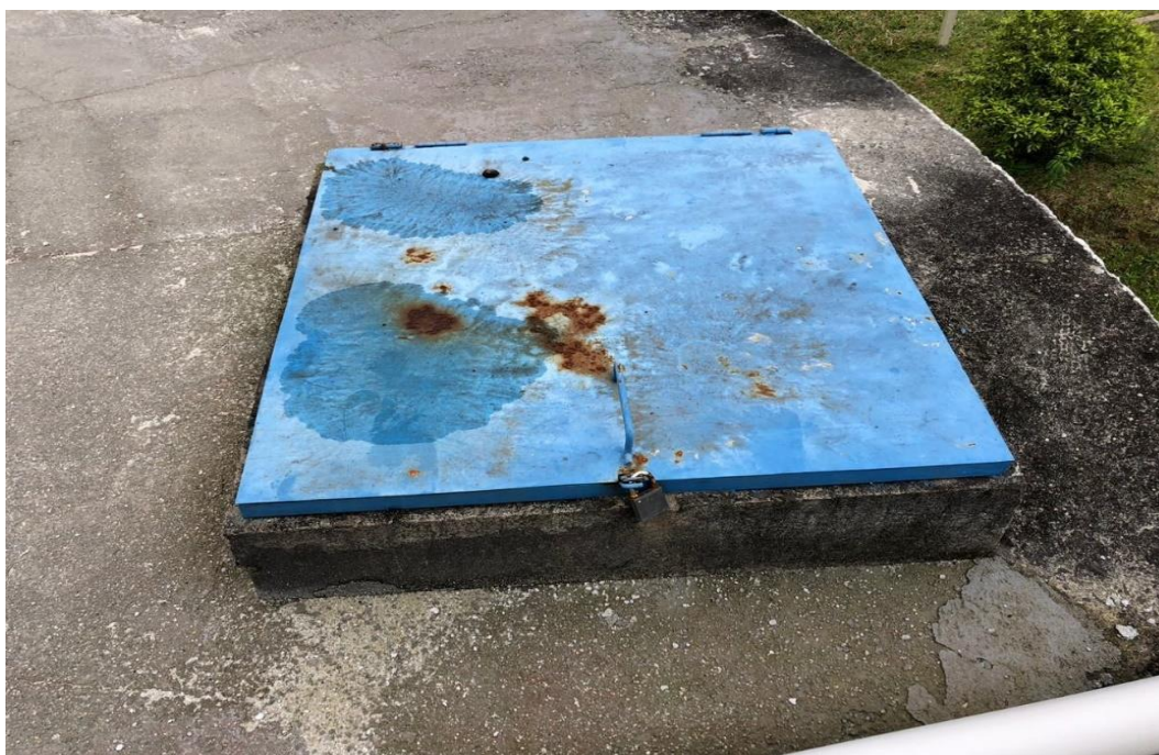
Figura 19: caixa inspeção com cadeado
