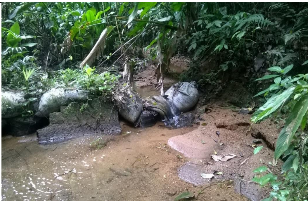
Figura 2: captação nascente Coral I
