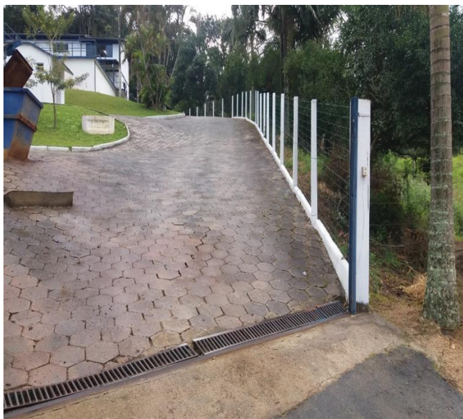
Foto 7: Entrada da ETA
