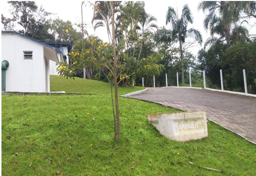
Foto 10: Pátio da ETA
