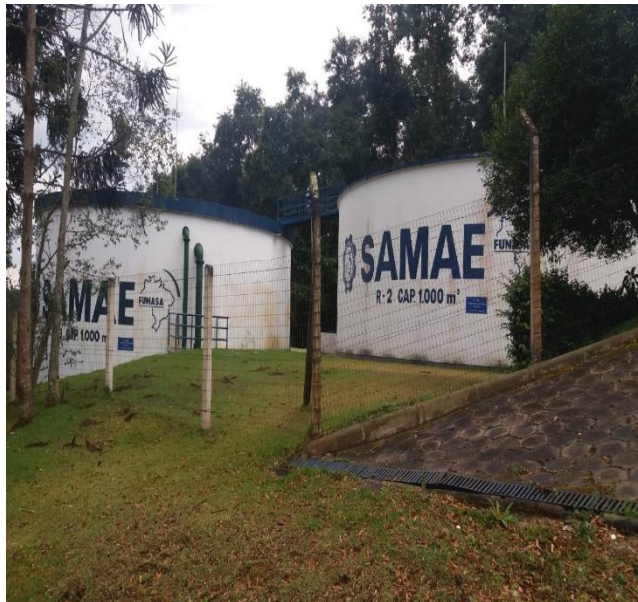
Foto 8: Lado esquerdo da ETA
