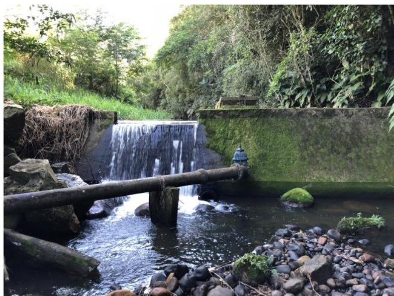
**Não conformidade:** Não foi evidenciado cerca para proteção em uma captação.
